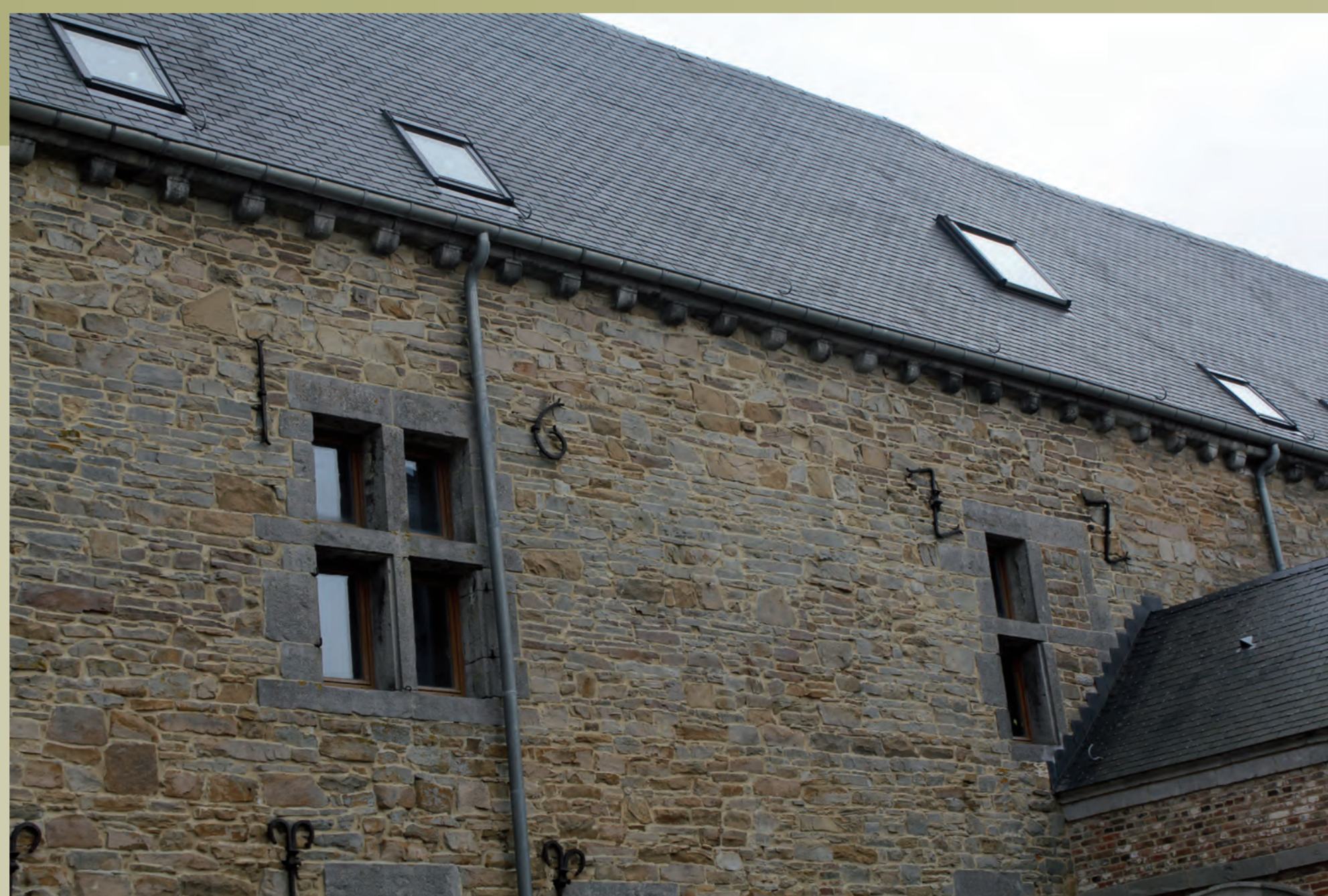
Ancres au logis. De ankers van het woongedeelte.
