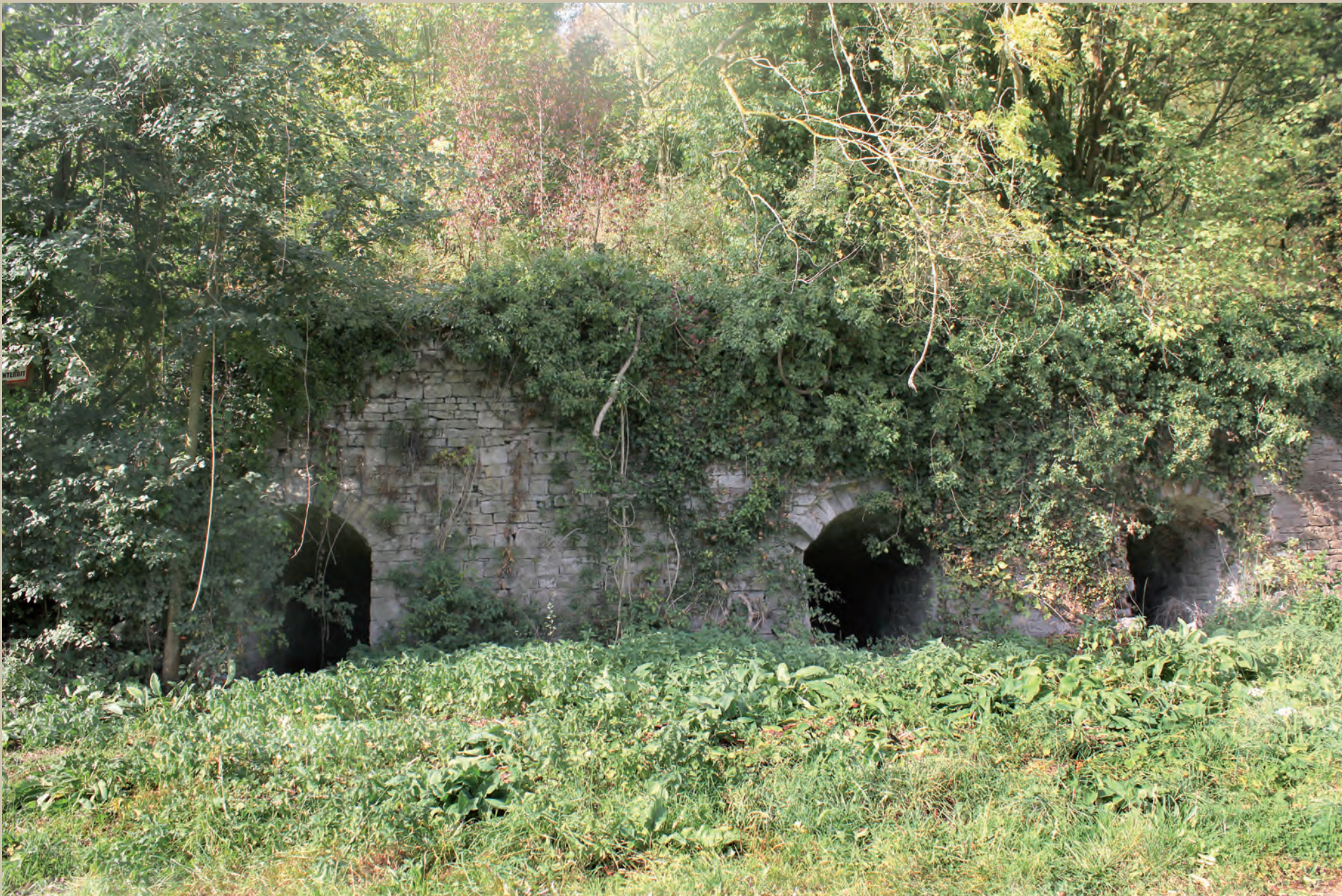
Fours à chaux. Kalkovens.
