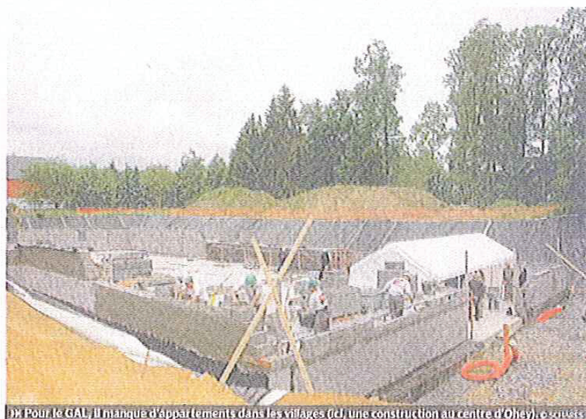
Pour le GAL, il manque d'appartements dans les villages (ici, une construction au centre d'Ohéy, en Gesves)
