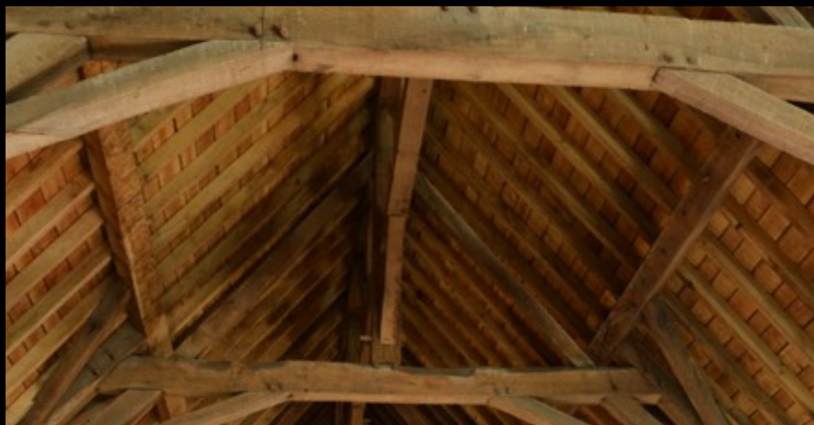
Charpente de l'église abbatiale de Floreffe © D. Belayew, 2016
