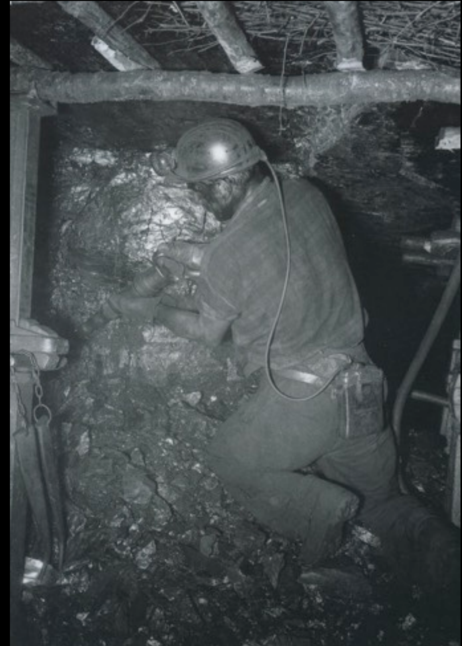
Abattage au marteau pic dans la taille de 6 Paumes du siège n° 14 des charbonnages de Monceau-Fontaine à Goutroux, cliché D. Deleuze, 1959, dans, Pierre Paquet (coord.), Le patrimoine industriel de Wallonie , Liège, Editions du Perron, 1994, p. 8.
