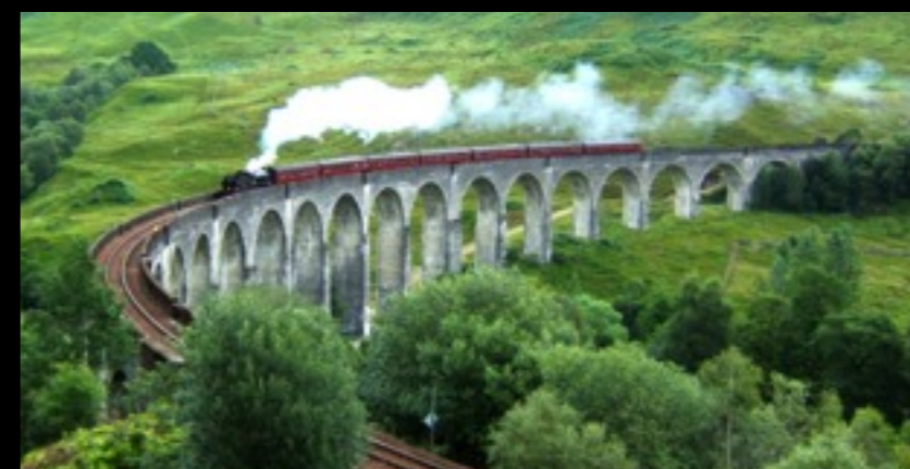
Viaduc de Glenfinnan
